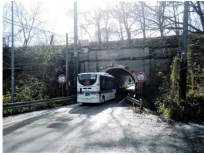
撤去前の様子
