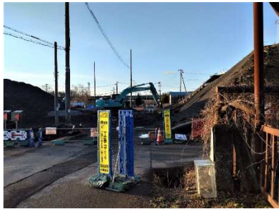
撤去工事の様子
